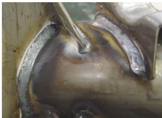
写真120-04 2.3t鋼管に1.6,1.8t亜鉛メッキ鋼板T字片面すみ肉パルスマグ溶接 (ブローホール発生なし良好)
